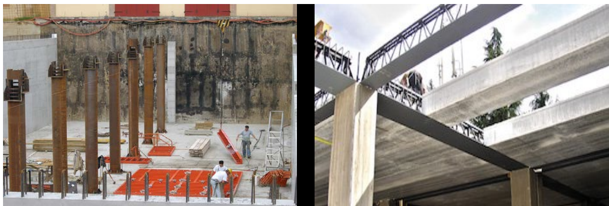
Fasi operative edificatorie
