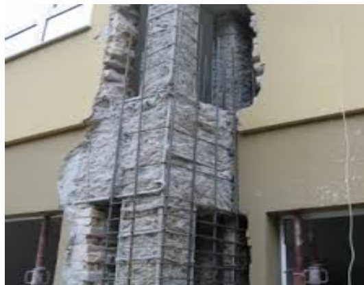
Consolidamenti Sismici
