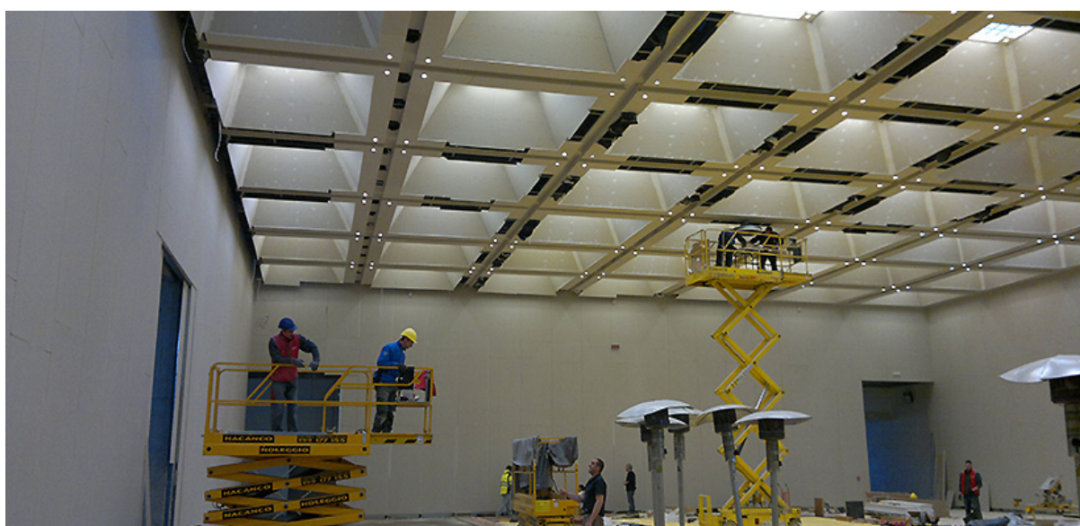
Finiture di interni commerciali – fasi operative
