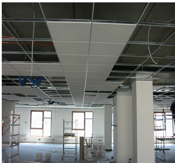
Finiture di interni commerciali – fasi operative
